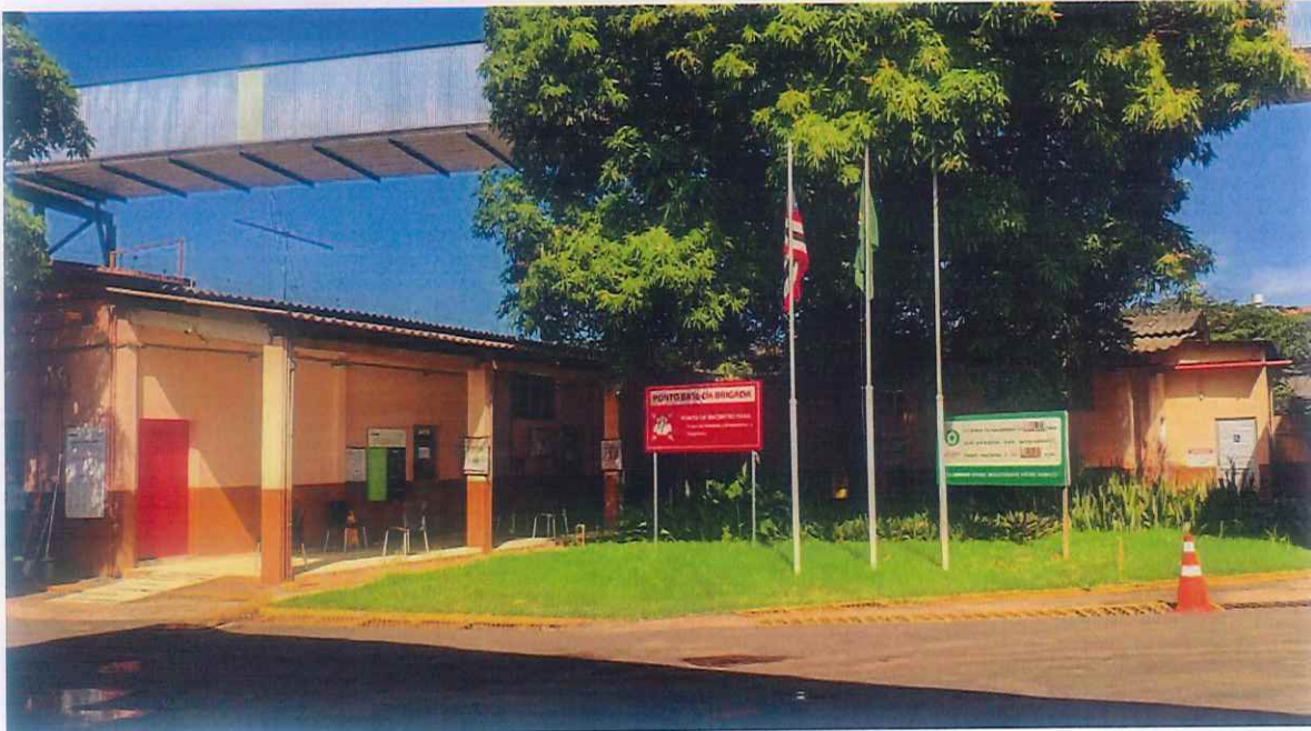
Imagem 23: Prédio Ambulatório, Recreação, Refeitório e Vestiários
