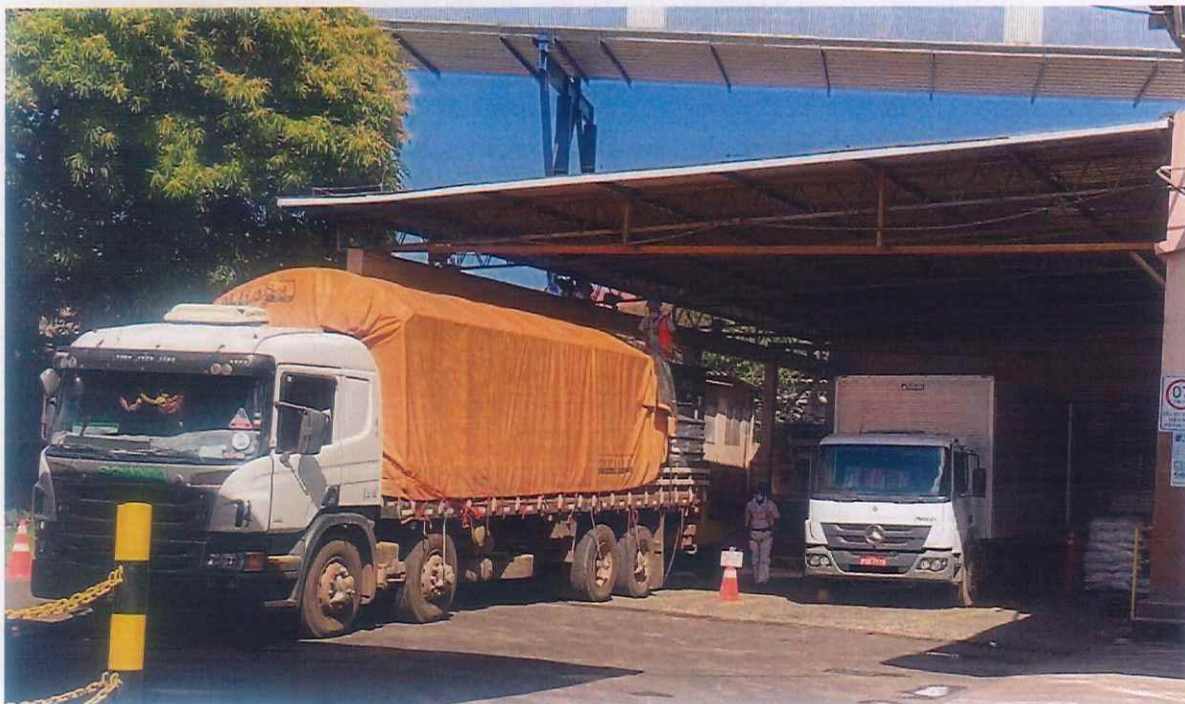
Imagem 21: Foto do prédio de Carregamento de Caminhões
